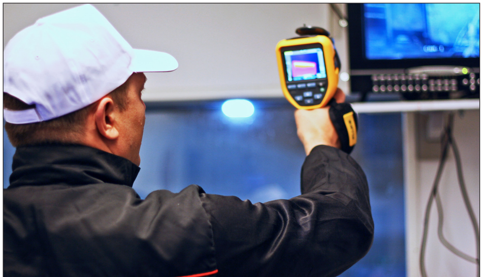
Timo Posio lämpökuvaamassa Karastin tilan navetan sähkölaitteita.
